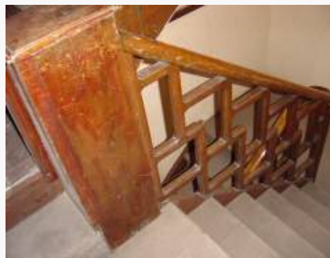
Detalle baranda escalera
