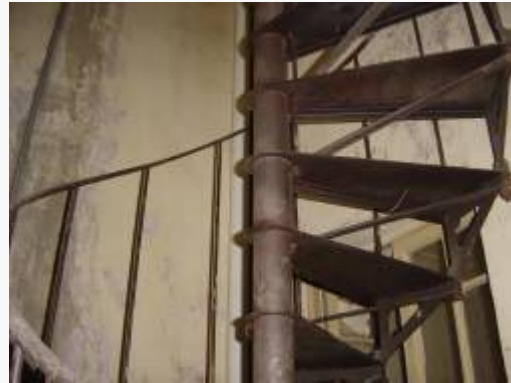
Escaleras de servicio
